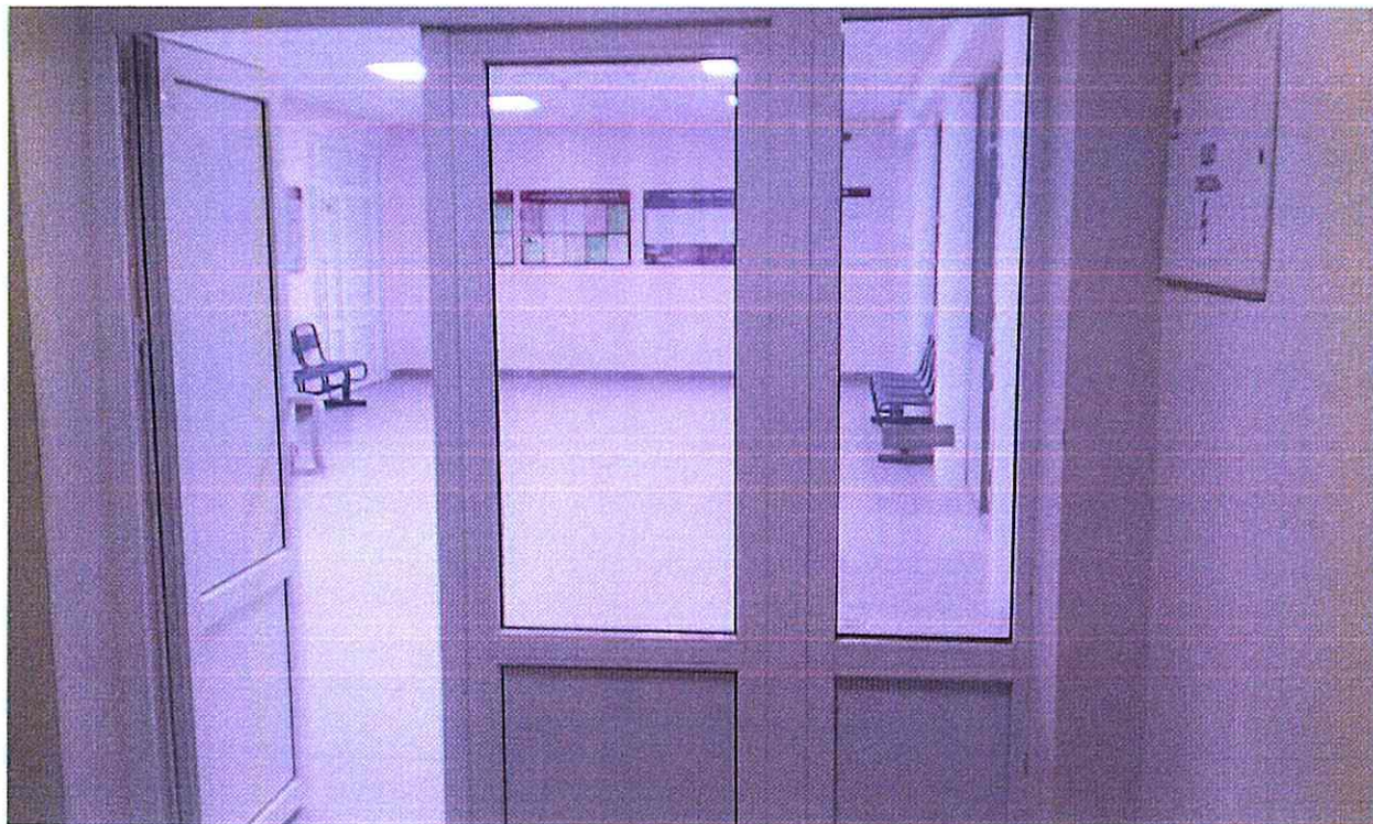
Фото Д.14 – Двери между вестибюлем и коридором
