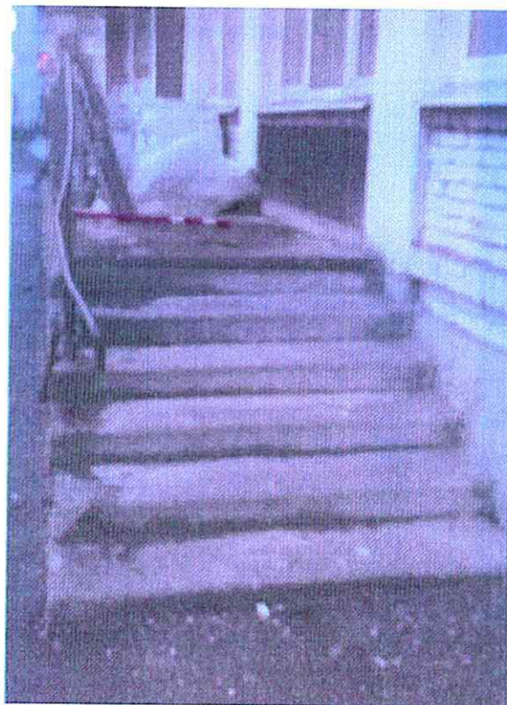
Фото Д.8 – Отрытая лестница к запасному входу
