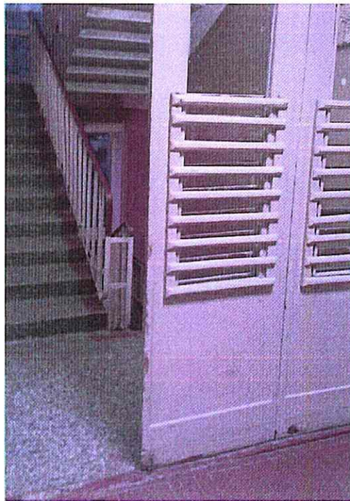
Фото Д.17-19 – Внутренняя лестница
