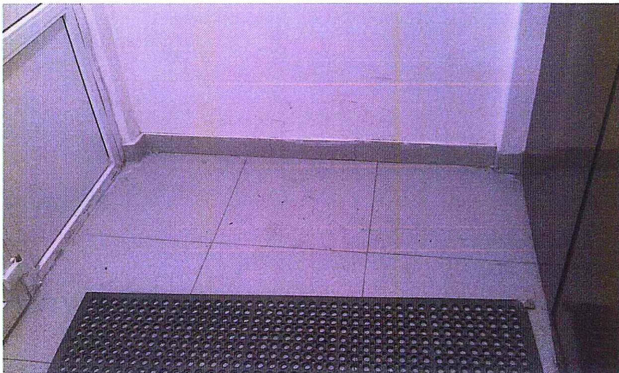
Фото Д.11 – Входной тамбур у входной двери
