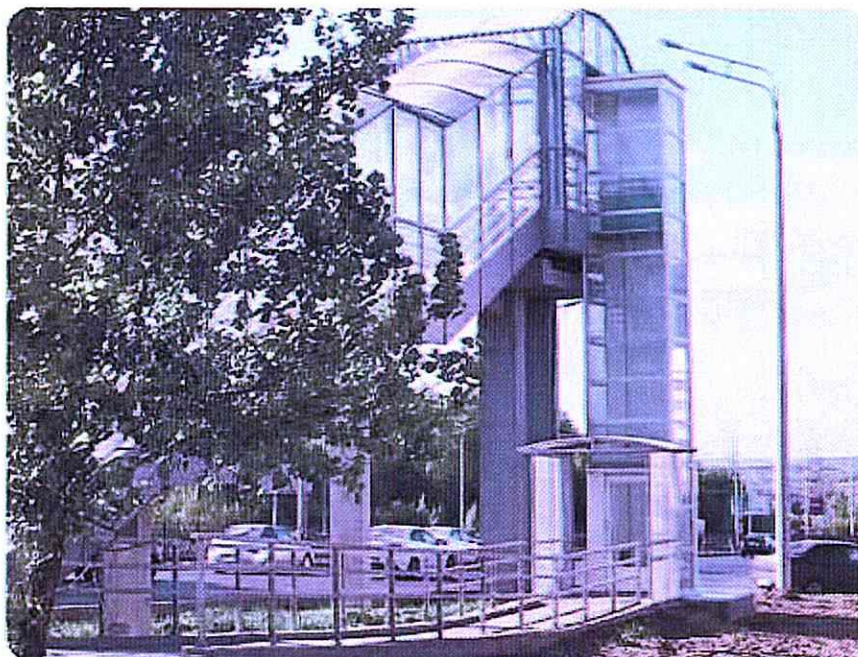
Рис. 8.11 Устройство лифта с внешней шахтой.
