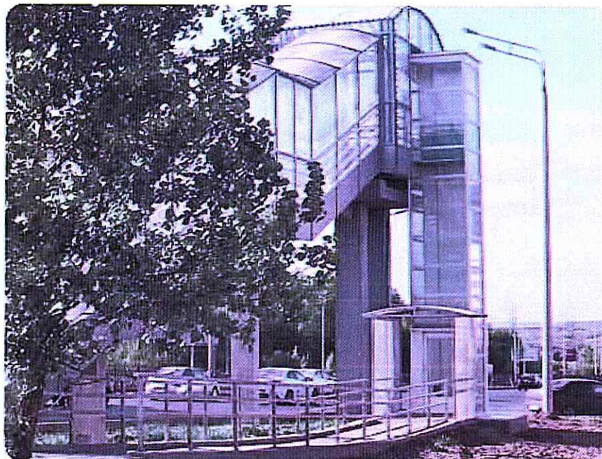
Рис. 8.12 Устройство лифта с внешней шахтой.
