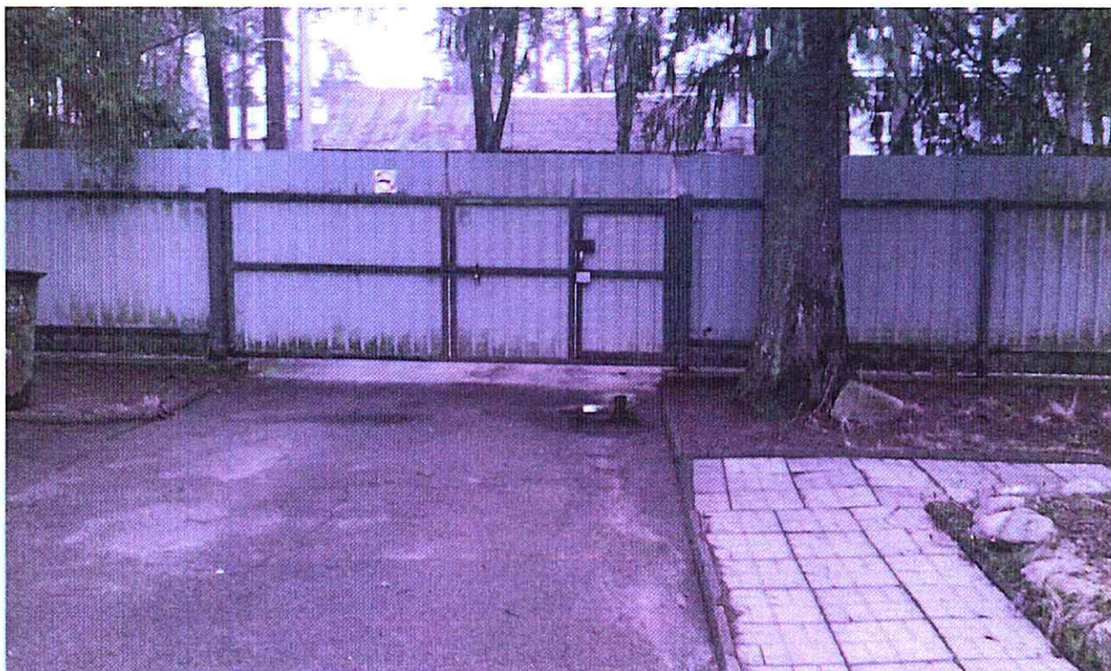
Фото Д.1 – Вход и въезд на территорию
